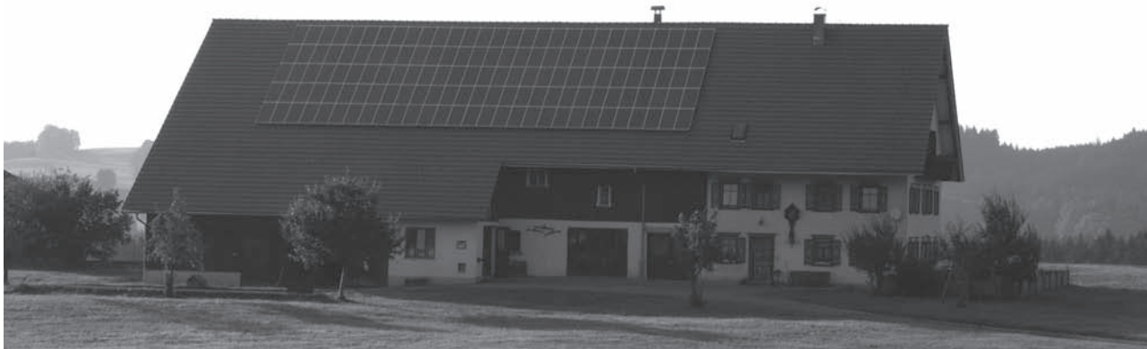
Abb.3: Photovoltaikanlage auf einem Bauernhaus im Allgäu
