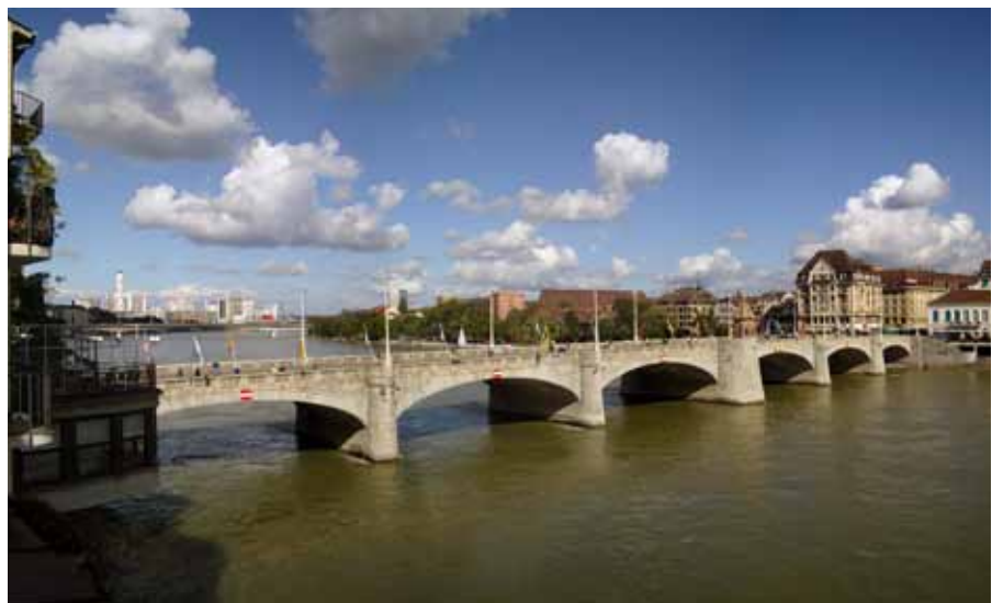
Mittlere Rheinbrücke in Basel (Foto: Juri Weiss)
